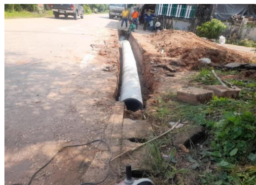
๕.โครงการวางท่อคอนกรีตเสริมเหล็ก จำนวน ๗ จุด ภายในพื้นที่ตำบลชัยภูมิ งบประมาณ ๑๖๔,๓๐๐.- บาท
